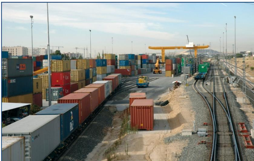
*Imagen1. Vista de la instalación: haz de recepción y expedición, haz de carga y descarga, zonas de acopio de contenedores.*
